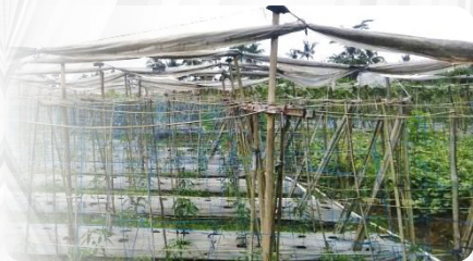
Kondisi Atap Plastik yang digulung
